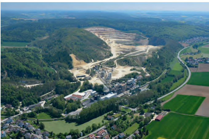
Blick auf das Kalkwerk am Ortsausgang Richtung Peterfecking
