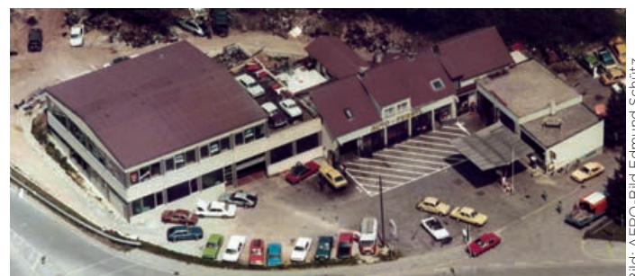
Blick auf die Gebäude und das Gelände des Autohauses Ferstl in den 1970er Jahren.
