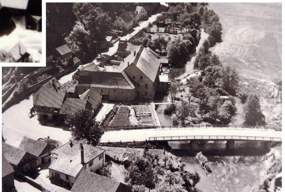
Luftbild der alten Laberbrücke
