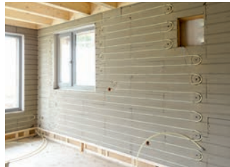
Lehmwand mit Wandheizung
