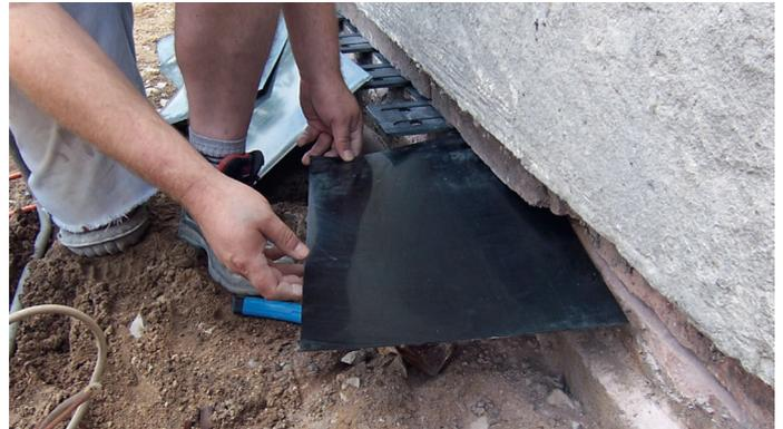
Einbringen einer Abdichtungsplatte bei nachträglichem Einbau einer Horizontalsperre mittels Mäuersägeverfahren
