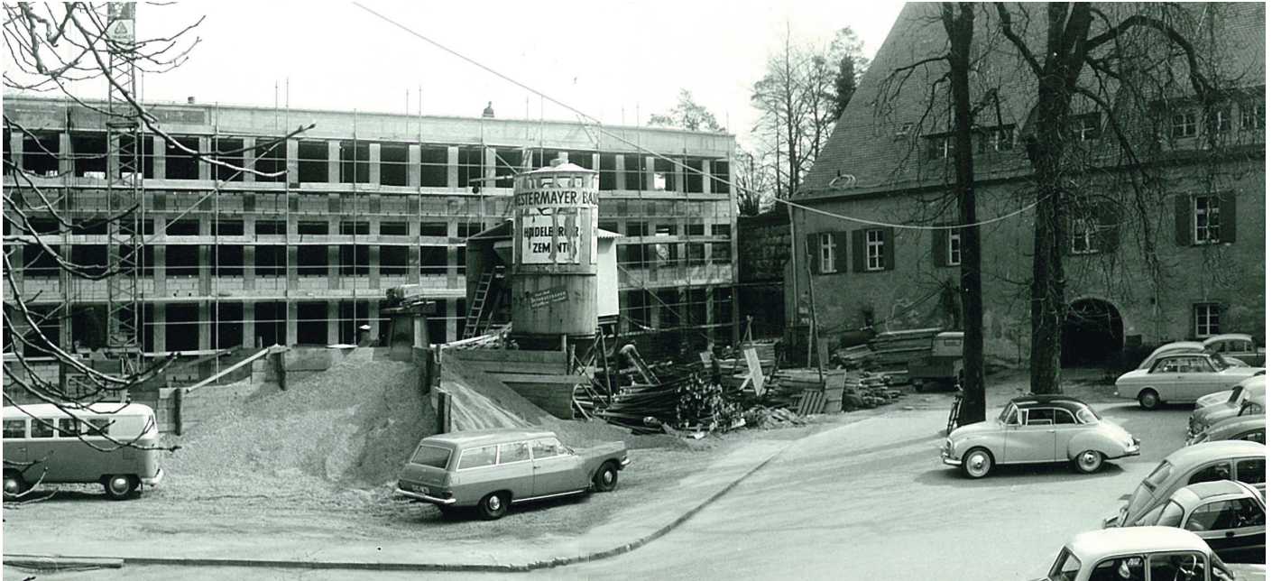
Von 1938 bis 2016 war das Wittelsbacher Schloss in Kelheim-Dienstsitz des Landratsamtes. Im Zuge der Gebietsreform mit Erweiterung des Altlandkreises Kelheim um Teile der vormaligen Landkreise Mainburg, Parsberg, Riedenburg und Rottenburg an der Laaber wurde nach dem Jahr 1972 ein Erweiterungsbau auf dem Schlossgelände notwendig.
